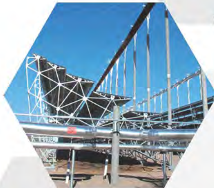
张北, 北京兆阳菲涅尔项目 Zhangbei, Beijing Terasolar Fresnel Project
